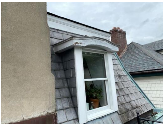
Figure (11) – Dommer window frame
